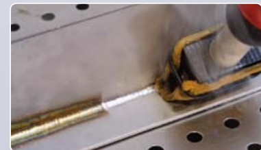
Altes Verfahren: Schweißnahtreinigung mit Tampon
